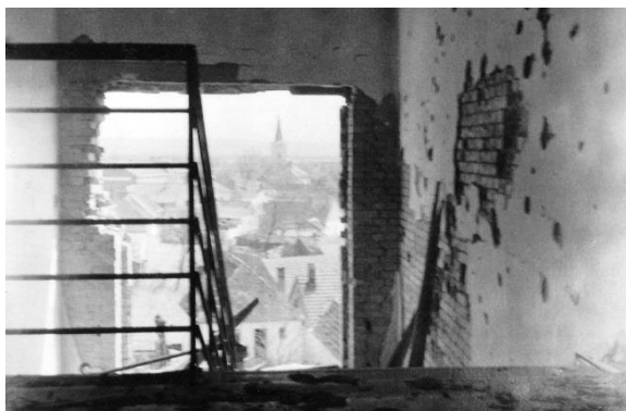
Okno na odpočívadle mezi I. a II. poschodím
