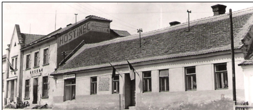
Fotografie domu č.145 asi z roku 1960 – dnes zbořeno
